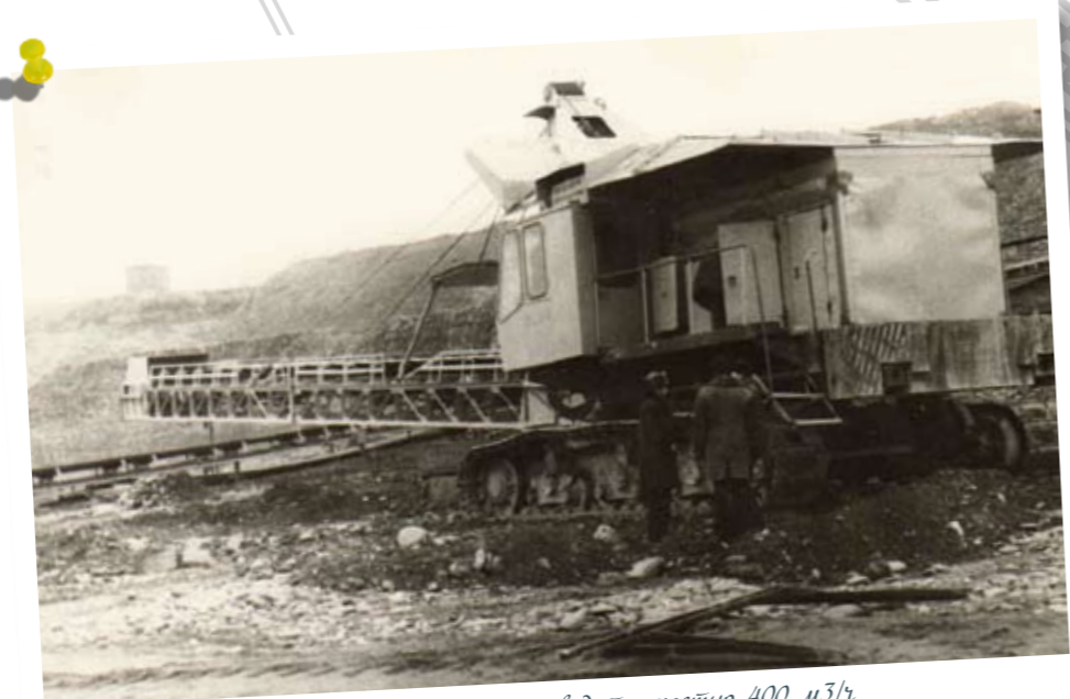
Самоходный бункер-питатель СМД-159 производительностью 400 м 3 /ч
